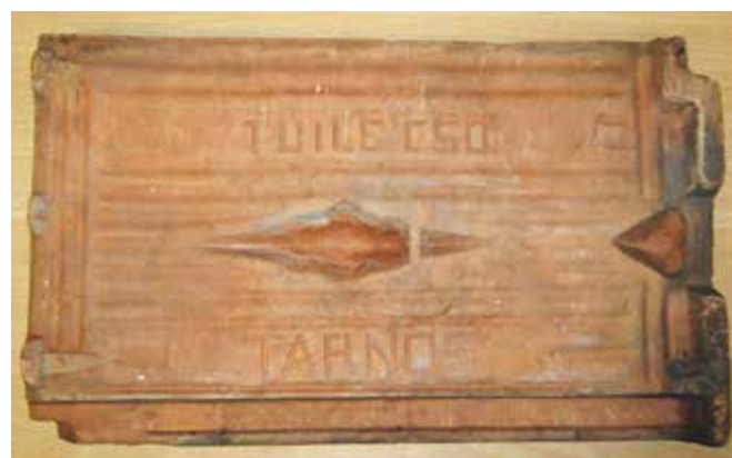
Ci-dessus : Photographie d'une tuile estampillée « Tuile CSO-Tarnos », dimensions : L45 x l25 x h3cm. Sans date- Collections municipales- Don privé La mention « terre molle » est également inscrite sur la tuile. Elle fait sans doute référence à un des procédés de fabrication des tuiles plates, qui s'effectuait en « pâte molle » ou « pâte dure ».
