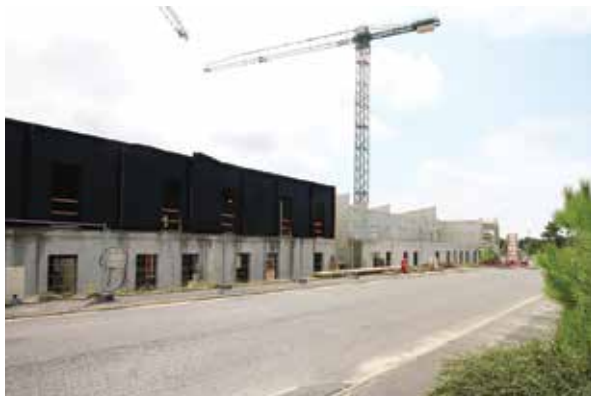
La construction du Centre de Formation. Photo : 1 er sept. 2017
